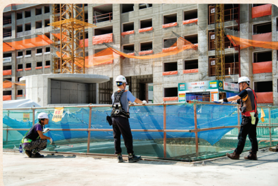
3. 대형 개구부의 안전난간 및 낙하물 방지망은 수시 점검한다.
