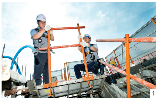
1 최상층 안전난간대의 하부를 점검한다.
